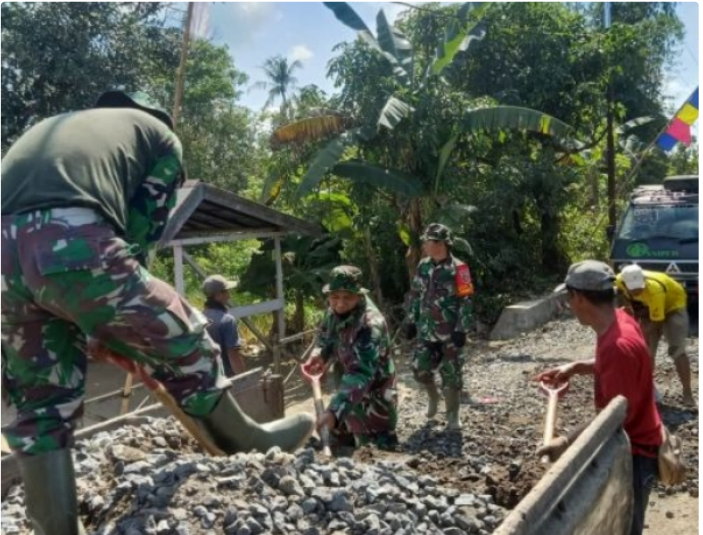
Satgas TMMD ke-113 Kodim 1005/Barito Kuala Lanjutkan Pengerasan Jalan
