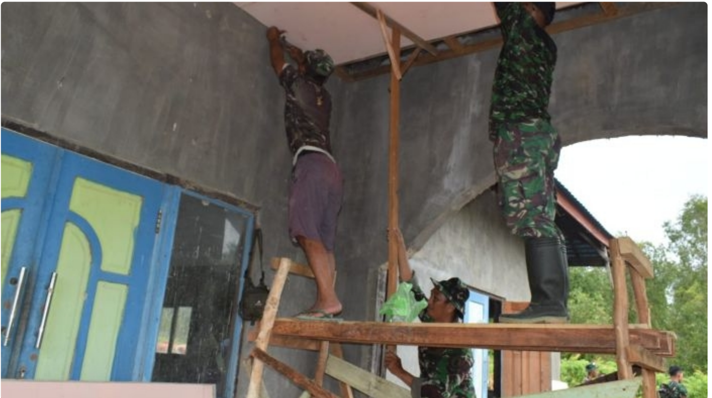
Anggota Satgas tMMD Pasang Plafon Masjid
