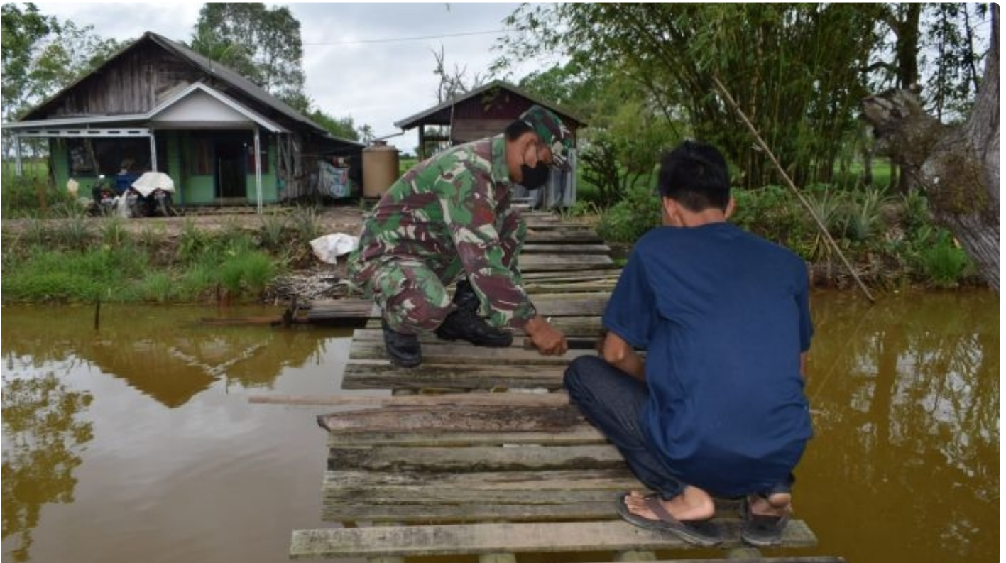
Babinsa Kodim 1005/Barito Kuala Bantu Perbaikan Jembatan
