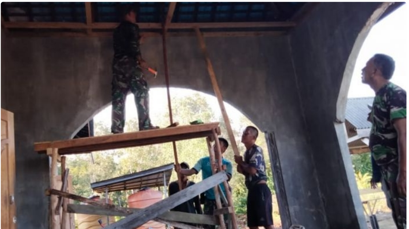
Anggota Satgas TMMD Gotong Royong Rehab Mesjid Jami
